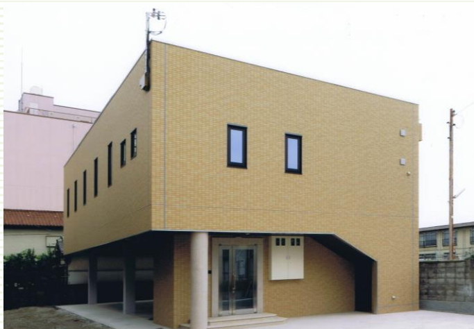
イーストビル新築工事
