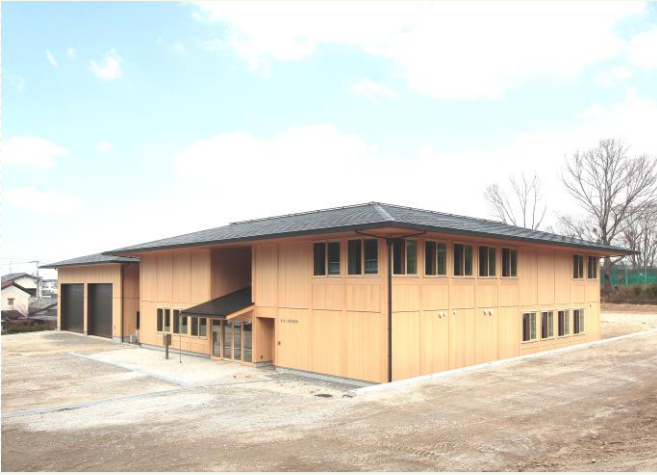
奈良公園管理事務所新築工事
