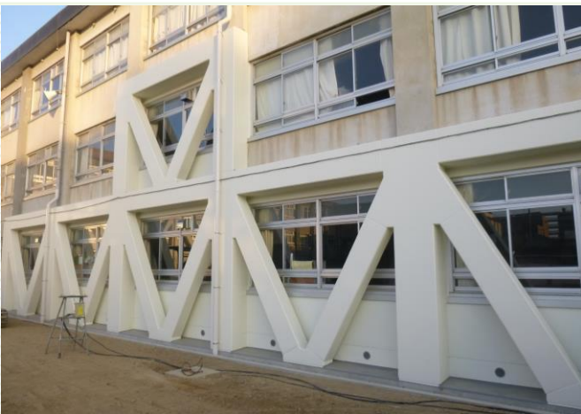
富雄北小学校耐震補強工事
