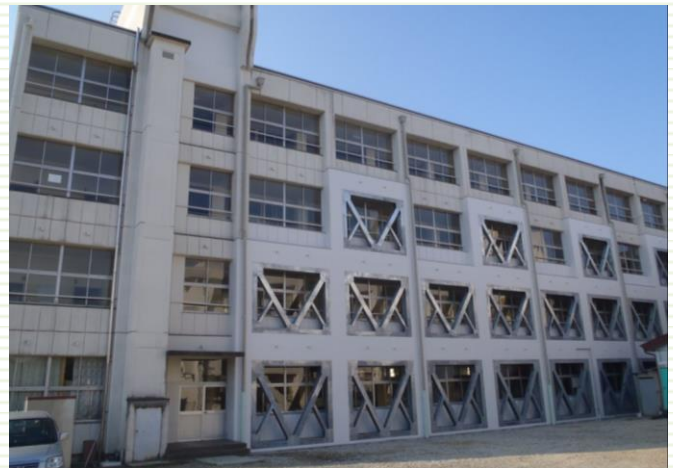
青和小学校耐震補強工事
