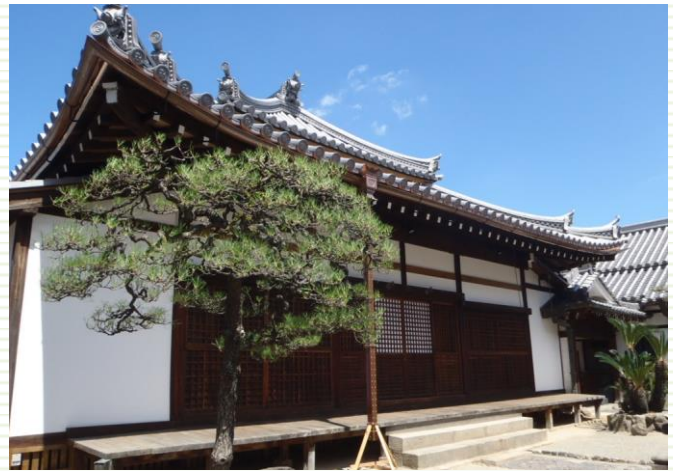
佐保山普光院本堂修復工事
