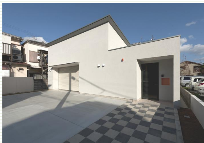
森内邸新築工事
