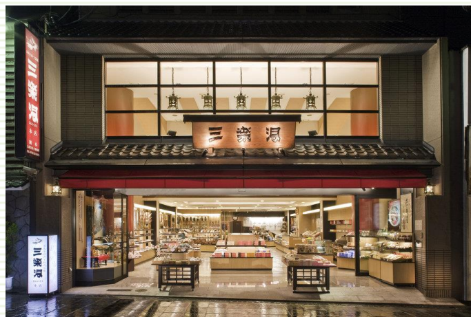
三楽洞東向店改装工事
